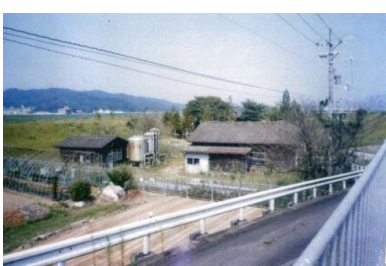
<解散時の天神橋簡易水道施設>
